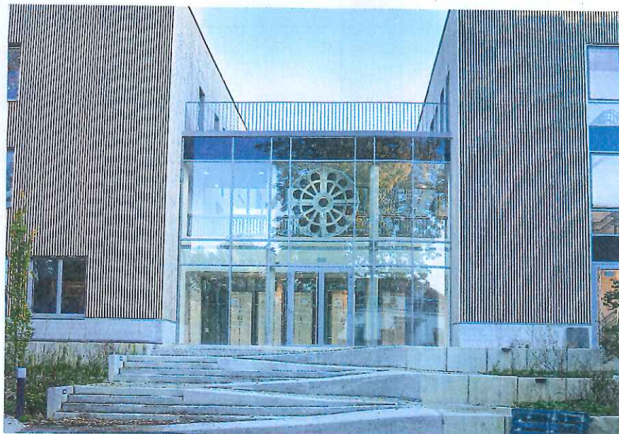
Le bâtiment ALPHA, sur la chaussée de Waterloo - 1504, est en phase finale de rénovation.
